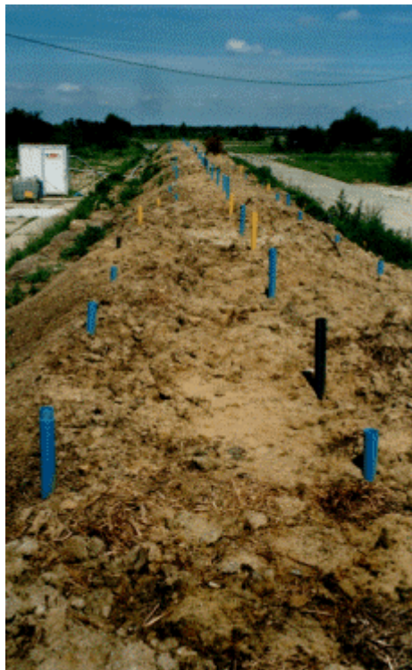
Rys. 1.15. Wentylacja bierna gruntu przy użyciu perforowanych lanc
