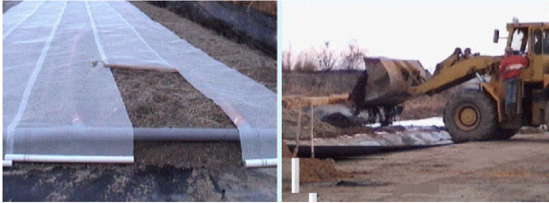
Rys. 1.21. Formowanie pryzmy z systemem drenującym
