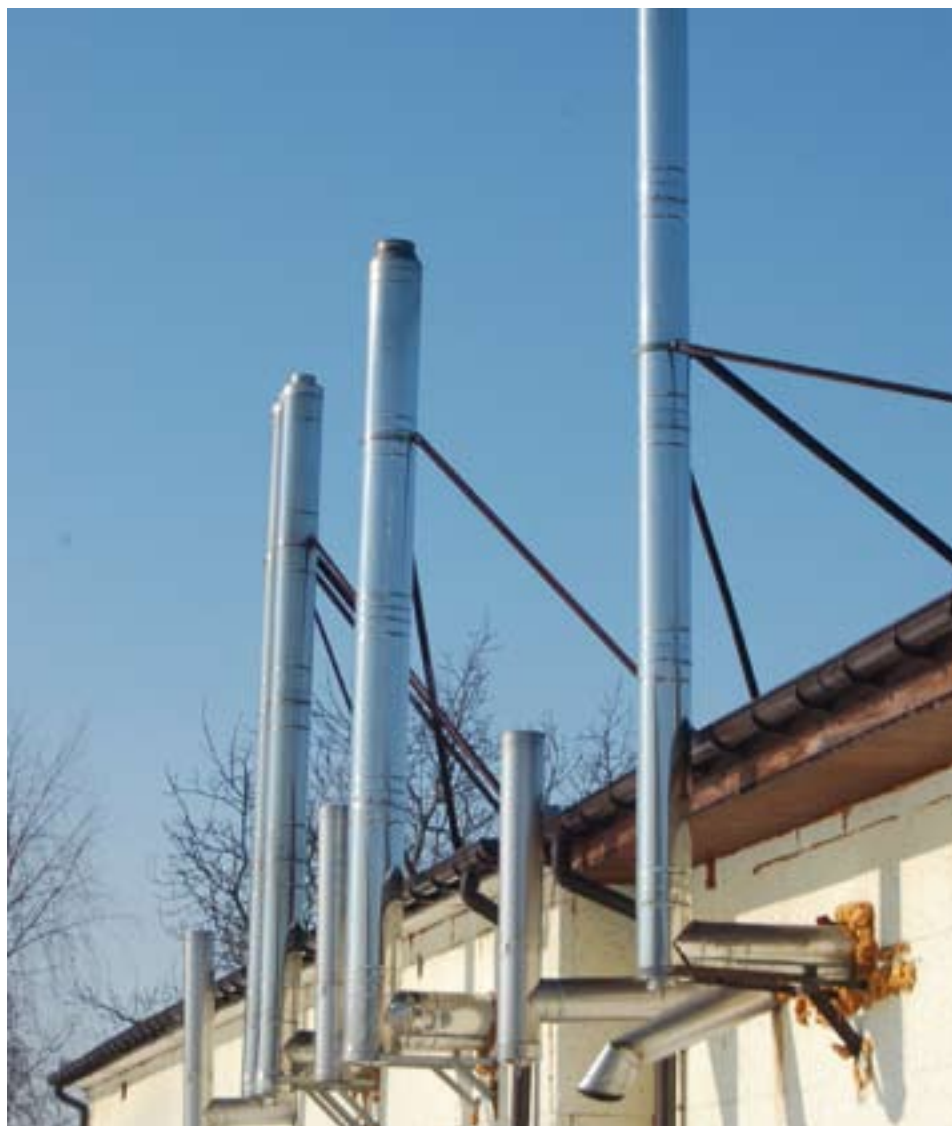
Bezpośredni wyciąg ciepłego powietrza i pary wodnej prosto z pieców i wydalenie ich poprzez nowoczesny system kominowy pozwala znacznie zmniejszyć wzrost temperatury w piekarni. Na zdjęciu: kominy w piekarni w Różynach. Fot. B&S
