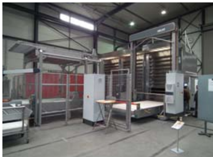
W trakcie zwiedzania niemieckiej fabryki goście mieli niepowtarzalną możliwość przyrzeć się z bliska piecom półkowym VATO, które znajdowały się na różnych etapach produkcji. Fot. HEUFT
