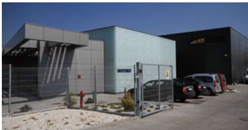
Budowa trwała dziesięć miesięcy. FOT. CREAM
