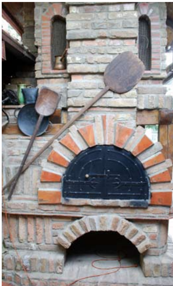
W miejscu, gdzie jest łuk drzwiowy, najlepiej postawić się ceglami w kształcie klina. FOT. SHUTTERSTOCK
